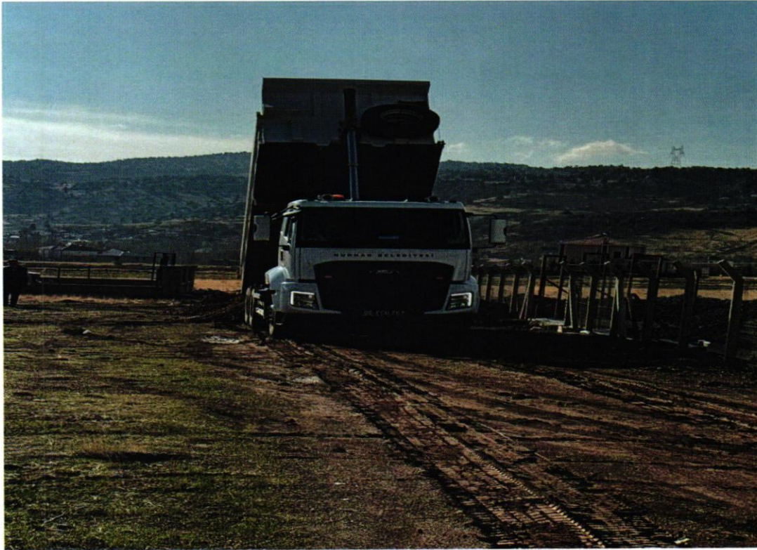
Yol bakım onarım çalışmaları
