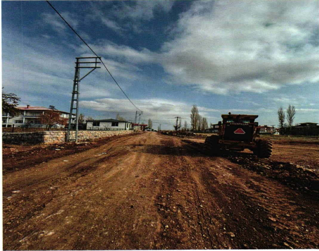
Halil Bey Caddesi yol genişletmesi ve istinat duvarı çalışması.
